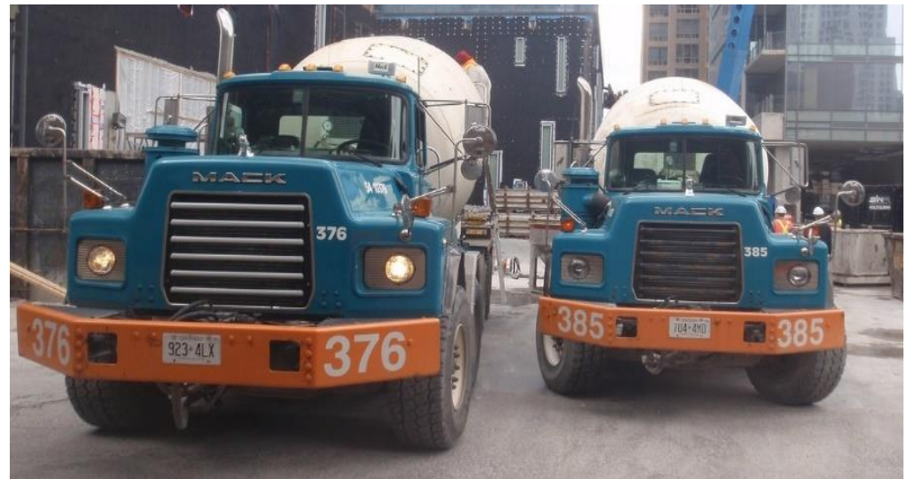
Camiones de concreto organizados cerca de área de construcción. (*7)
