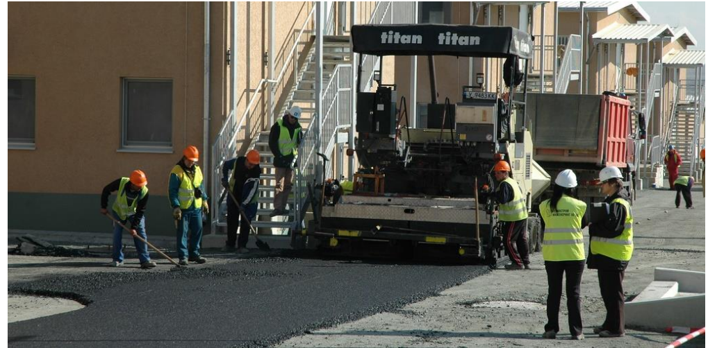
Trabajadores utilizando chalecos de seguridad de alta visibilidad. (*6)
