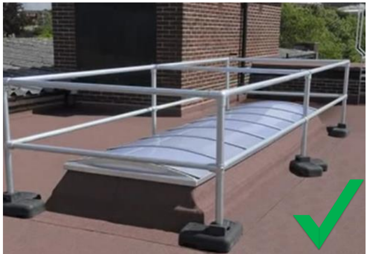
Instalación temporal de barandales alrededor de éste tragaluz. (*6)
