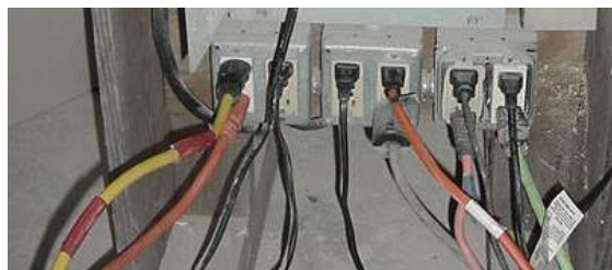
Preparación temporal común de un panel eléctrico con tomas de corriente GFCI encontrados en un sitio de construcción.
