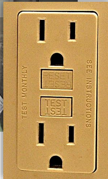
Toma de corriente GFCI con botón de prueba y reinicio. (*5)
