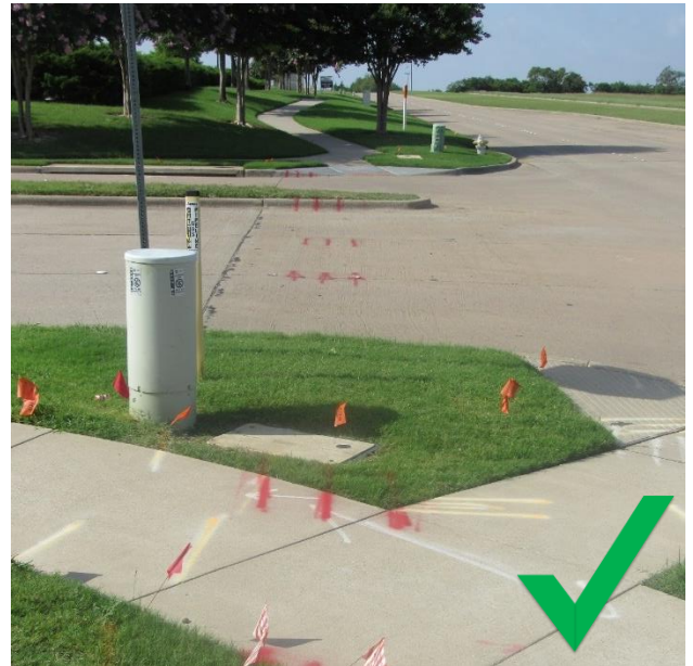
Ejemplo de ubicación en intersección y área de banqueteta. Nota que la electricidad está marcada con pintura roja, teléfono con banderas naranjas y combustible en pintura amarilla.
