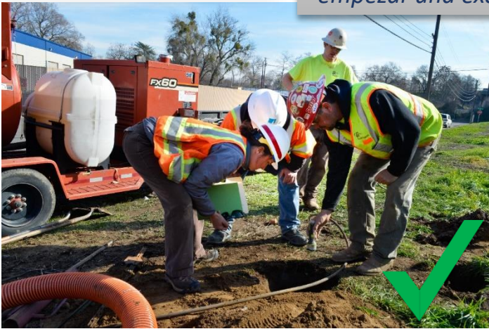
El equipo busca una línea de gas enterrada en un pozo recién cavado. (*8)
