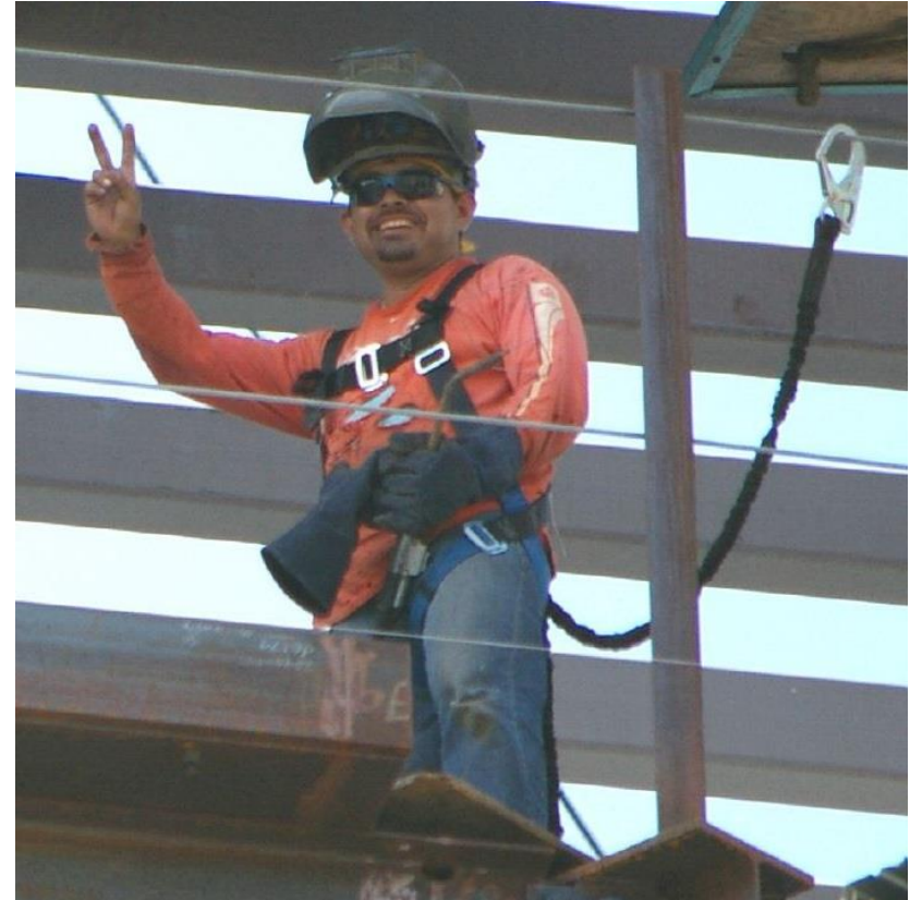
Trabajador usando protección de ojos, protector de cara está listo para ser usado cuando se necesite para actividades como soldar/cortar. (*1)
