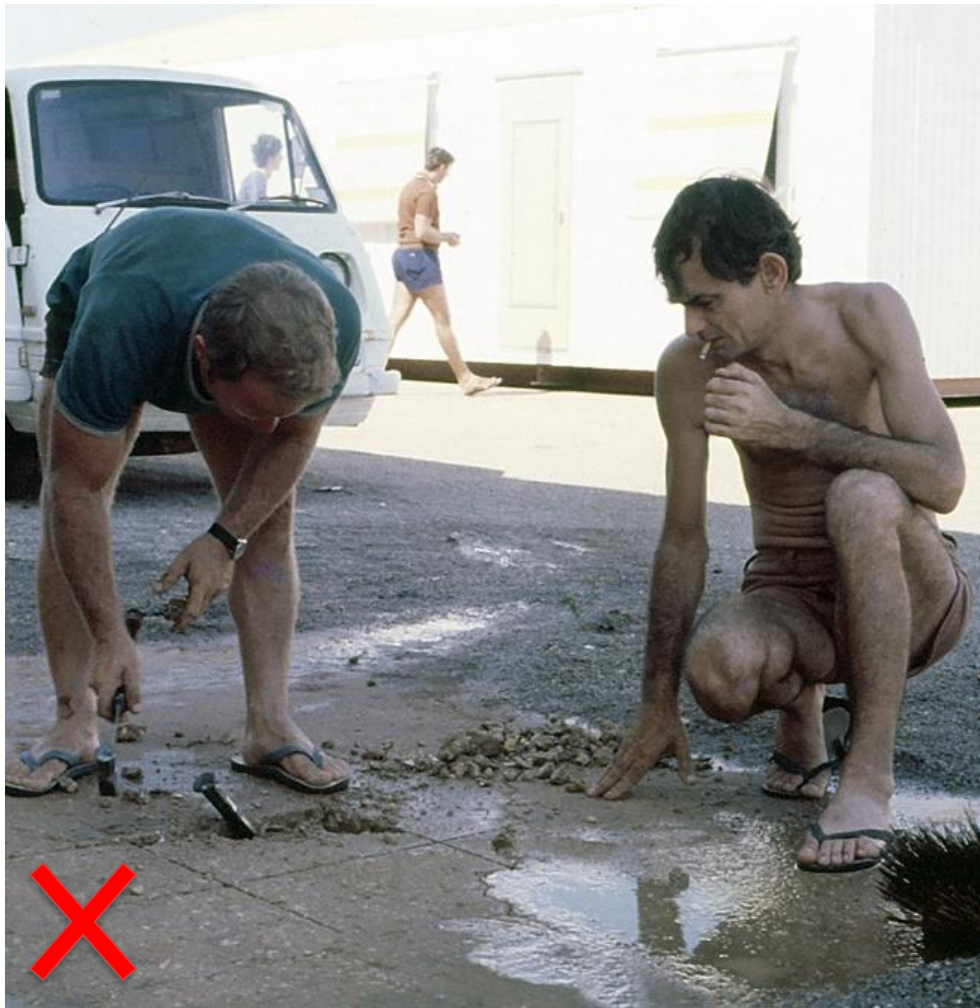
Dos individuos trabajando sin equipo de protección personal y expuestos a potenciales lesiones serias de ojos. (*3)
