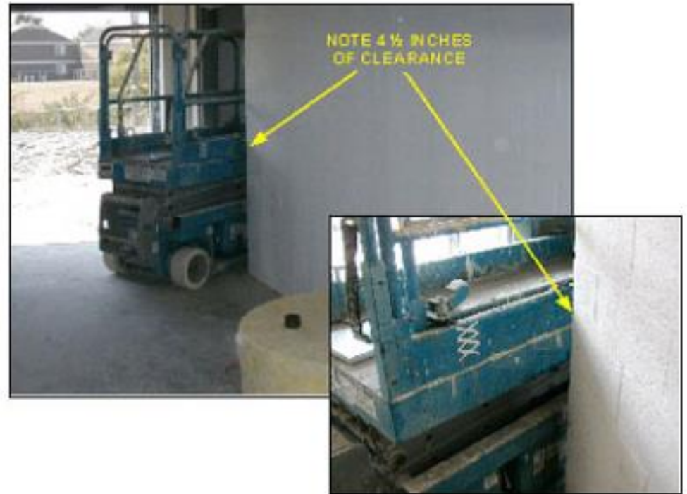
Imagen de la investigación de una fatalidad donde un trabajador de medio tiempo de 42 años murió cuando el elevador de tijera que estaba operando se elevó y lo sujetó contra la cabecera de una puerta interior. REPORTE FACE Interno NIOSH 2003-01 (*6)
