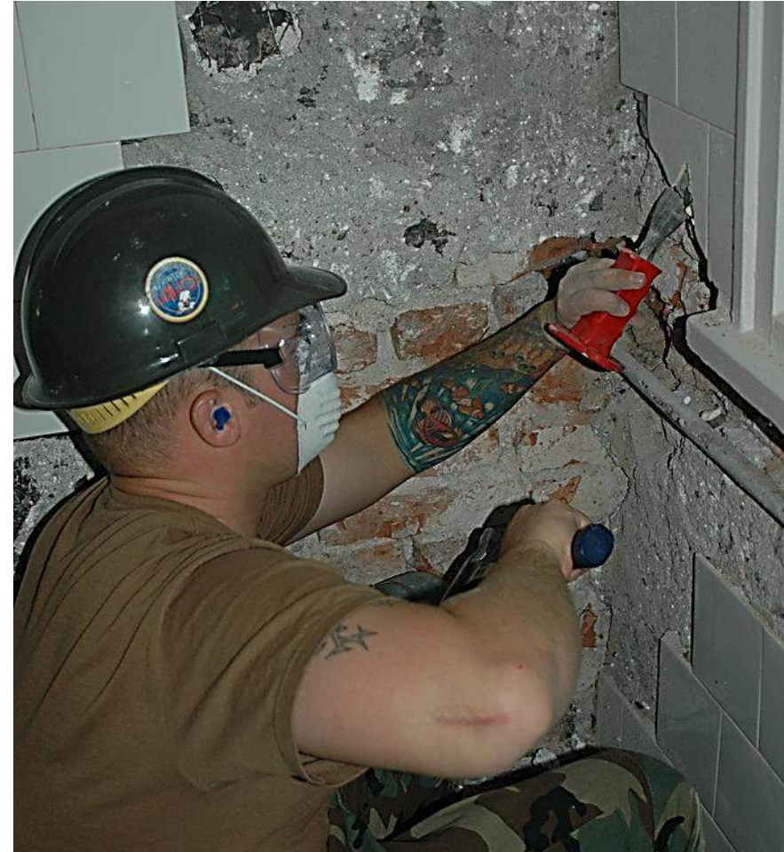
Trabajador usando un martillo y cincel para quitar azulejos. Nota el uso apropiado de Protección de Ojos en la forma de goggles de seguridad que incluyen protección de lados. (*1)
