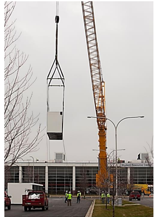
Personal levantando equipo al techo. Nota que el estacionamiento ha sido despejado de uso público para la seguridad de los peatones. (*6)
