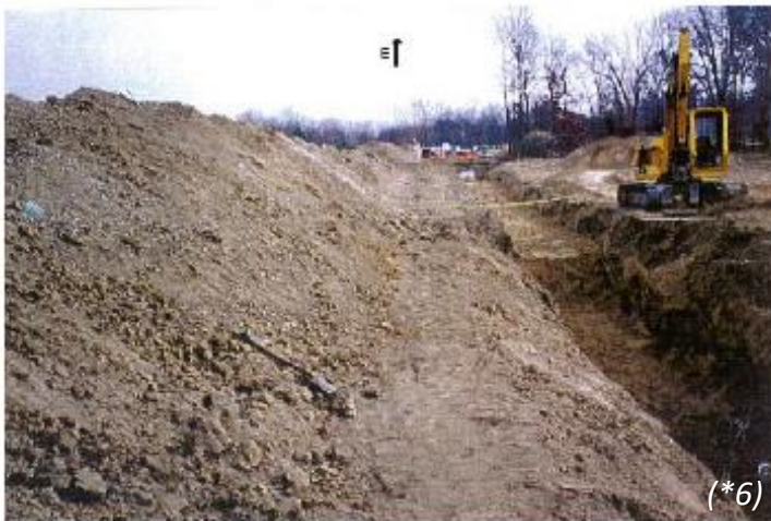
Figura 1. Proyecto de Instalación de Drenaje (Zanja mostrada tiene alrededor de 200 pies de largo.)
