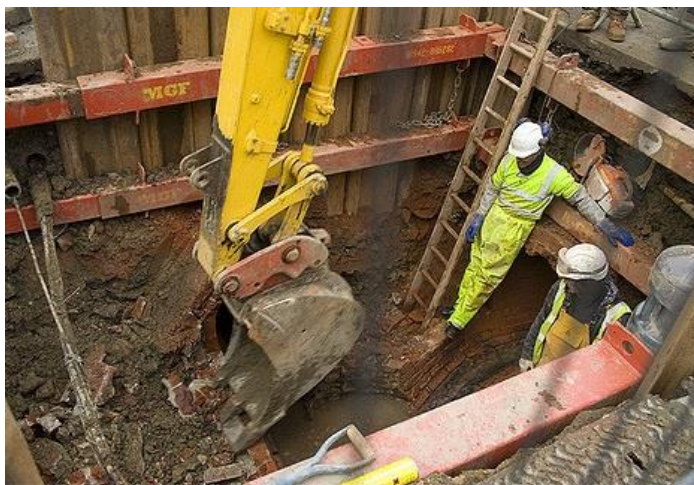
Un sistema de apuntalamiento de madera. (*5)
