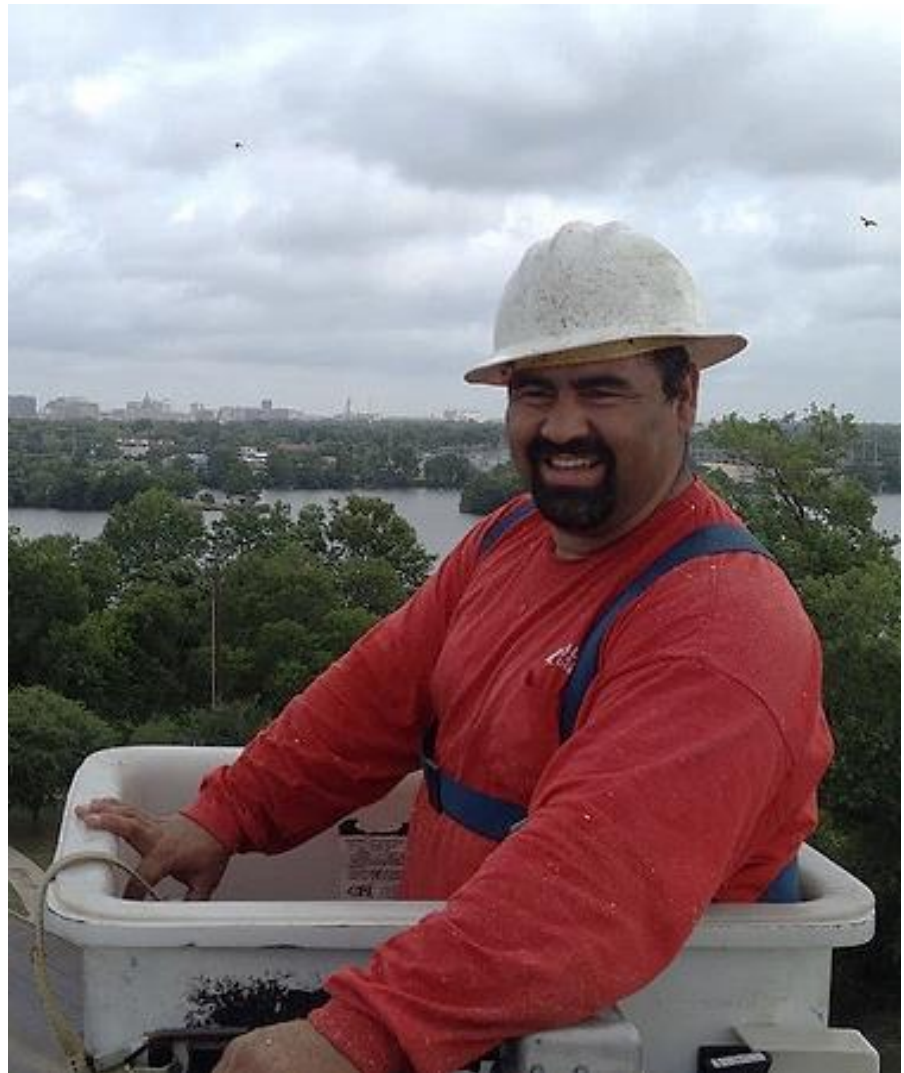
Trabajador dentro de un camión elevador con canasta. Nota que está usando un arnés y el punto de conexión en la parte inferior de la foto tiene un cordón conectado. (*6)
