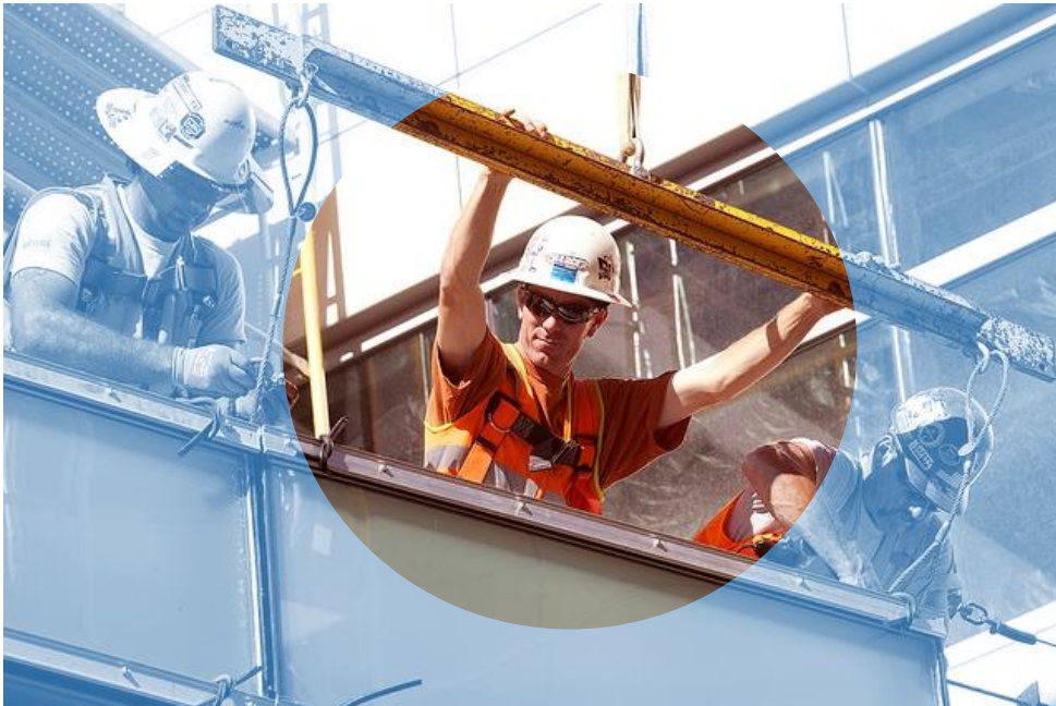
Vidrieros usando lentes de seguridad adecuados trabajando para fijar ventanas. (*1)
