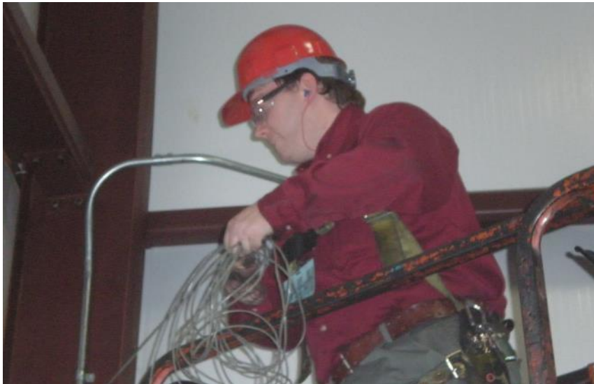
Trabajador en elevador de tijera usando gafas de seguridad apropiadas. (*2)
