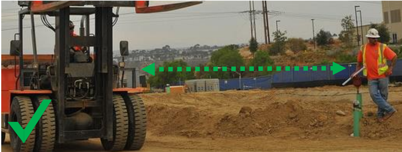
Manejando el montacargas a través del sitio de trabajo. Nota como el personal del sitio se mantiene a una distancia segura. (*6)
