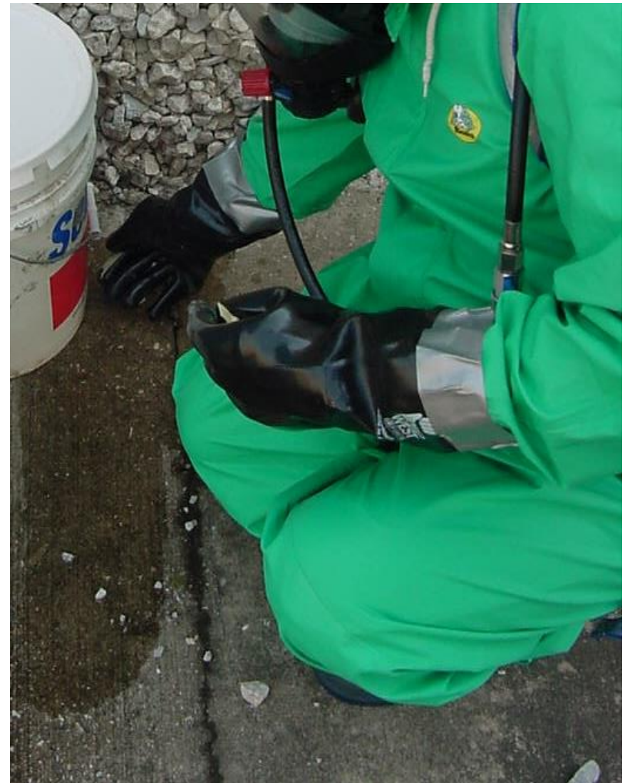
El trabajador en esta imagen con guantes especializados resistentes a químicos junto con otro equipo resistente a químicos pesados.
