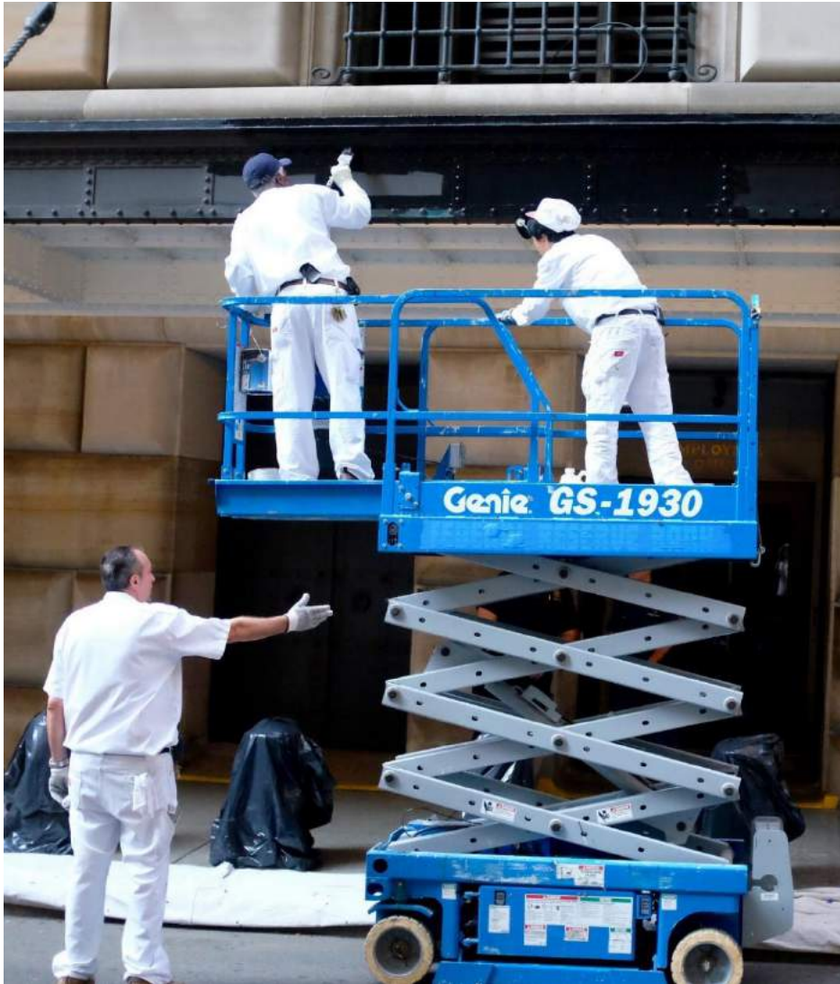
Trabajadores usando un elevador de tijera en el exterior de un edificio. (*1)
