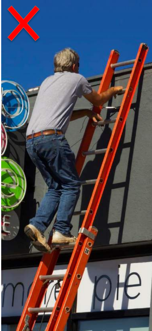
La escalera en ésta foto no se extiende 3' sobre la orilla de éste techo. (*3)
