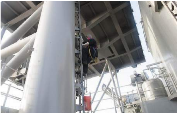
Este escalador está manteniendo apropiadamente tres puntos de contacto y usando un sistema personal anti-caídas. (*5)
