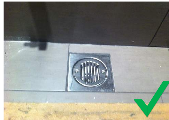
Drenaje de piso cubierto adecuadamente. (*4)
