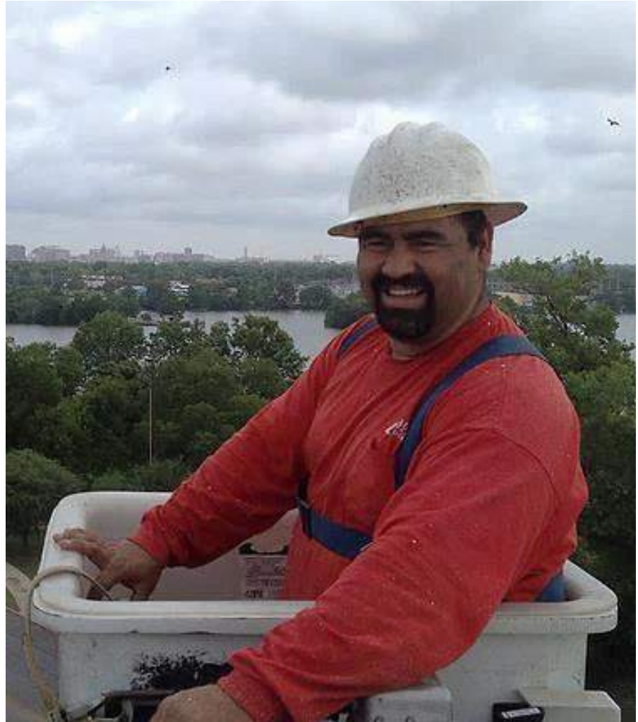
Trabajador dentro de un camión elevador con canasta. Nota que está usando un arnés y el punto de conexión en la parte inferior de la foto tiene un cordón conectado. (*9)
