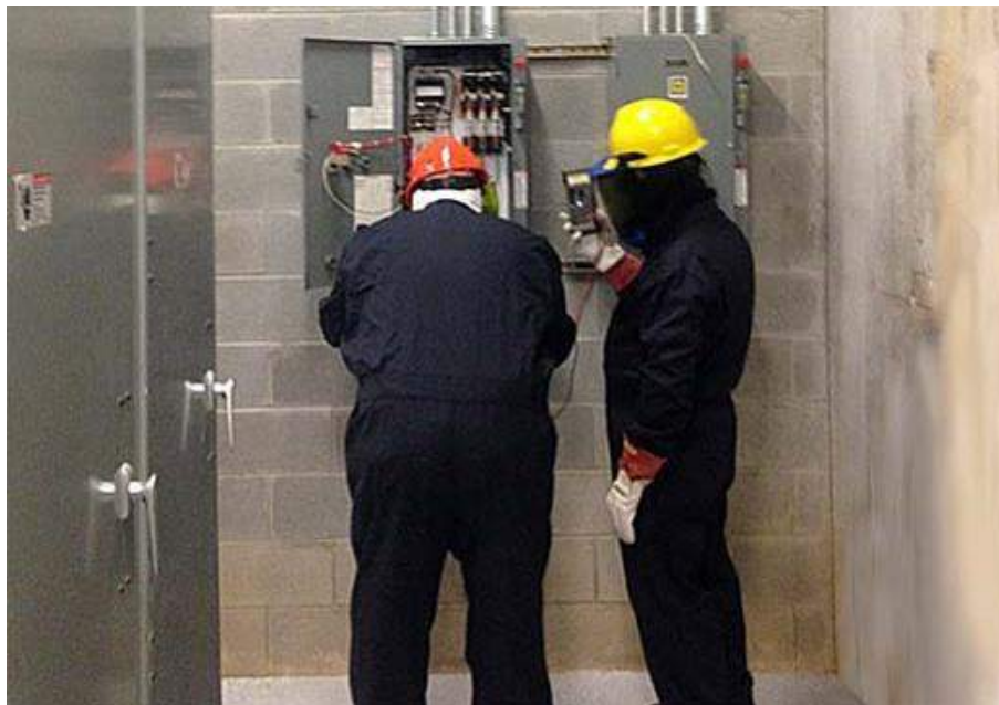
Trabajadores eléctricos usando equipo de protección personal adecuado. (*7)
