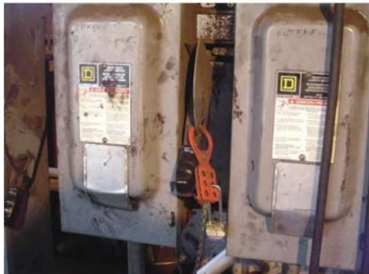
Foto 2. Esta foto ilustra el cuarto de descortezado sur donde los bloqueos se habían colocado en dos circuitos eléctricos por la víctima.
